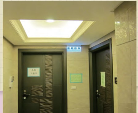
光世代建設：「光點」集合住宅_空間之照明光源均有防眩光隔柵、燈罩或類似設施。
