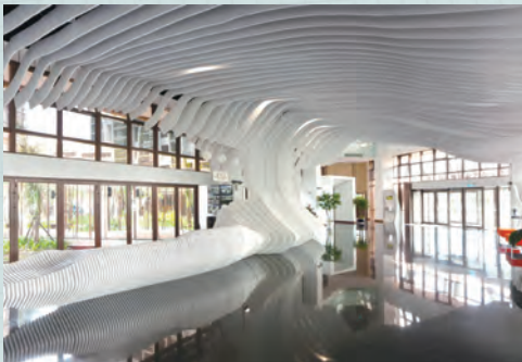
經濟部嘉義產業創新研發中心第一期新建工程：一樓大廳採用落地折門，可全面開啟達到自然通風效果，提供室內舒適涼爽空氣。
