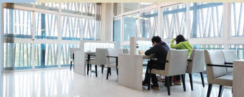
高雄市立圖書館小港分館：運用遮陽良好的玻璃窗，以達到自然採光目的。
