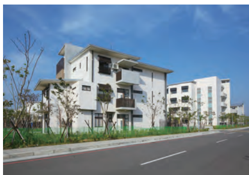
國立南科國際實驗高級中學：宿舍的外遮陽設計，阻隔戶外日照降低室內溫度，進而減少室內耗能。
